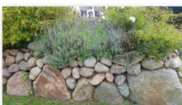
Mauer aus losen Steinen, mit Lücken für Insekten, Eidechsen, Kleintiere wie Spinnen oder Schnecken.
